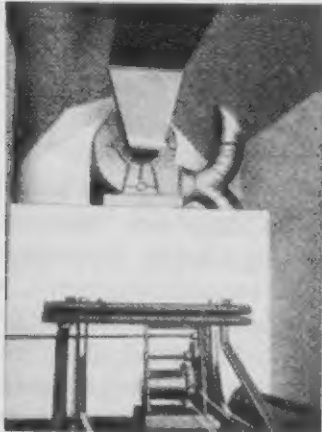
Abb. 38 Kreislauf- und Lüftungseinrichtung einer 400 cbm fassenden Eisenbahntentwesungskammer.
